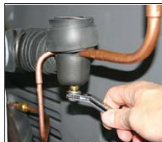
Ajustando la Válvula TXV
